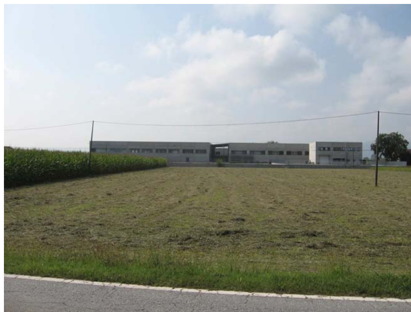
L'area C 19 vista da via Cardè
