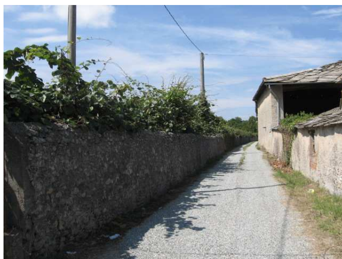
Imbocco di via Pista da via San Martino
